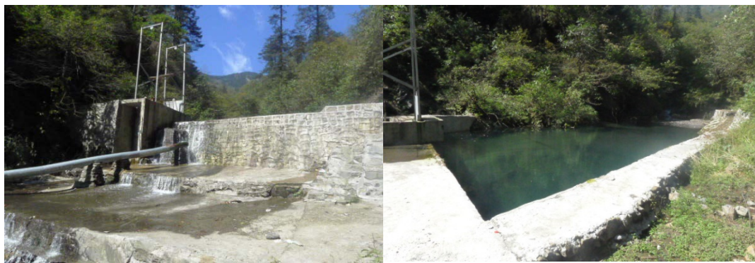
图 6-13 第二水源输送管道图 6-14 第二水源地
