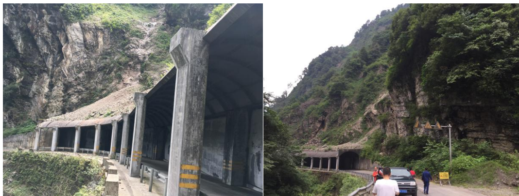
图 6-19，图 6-20 明洞恢复现状
